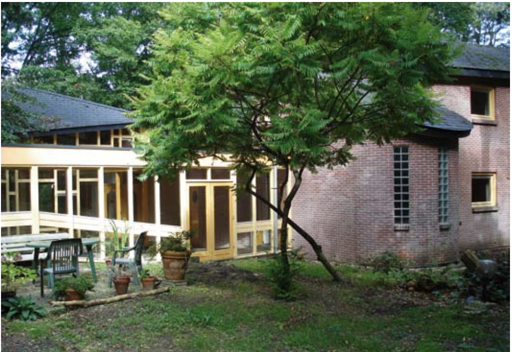
Zicht op Crystal House en een deel van de kloostergang
