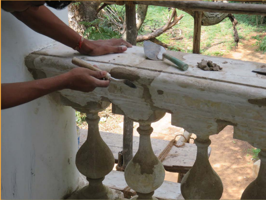
Foto: Renovatie Blavatsky Bungalow vraagt fijn handwerk. Zie www.adyar-renovation.org – The Project
