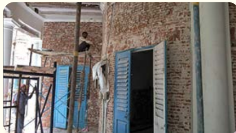
Links een scheur in de fundering, rechts het schoonmaken van de muren van cement pleister
