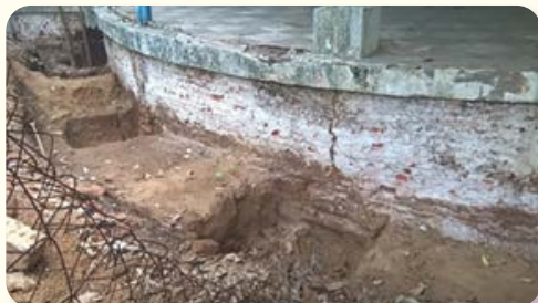
Links een scheur in de fundering, rechts het schoonmaken van de muren van cement pleister
